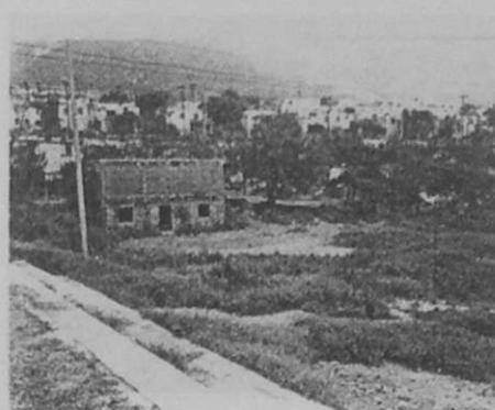
CONSTRUCCIÓN DE CANCHA
