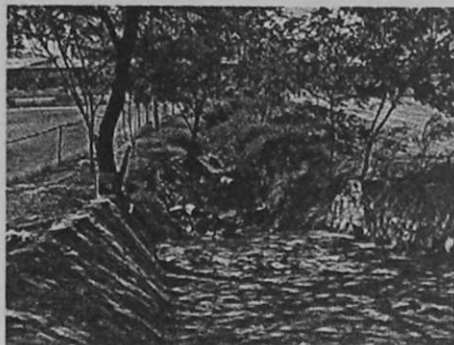
CONSTRUCCIÓN DE CANAL PLUVIAL
